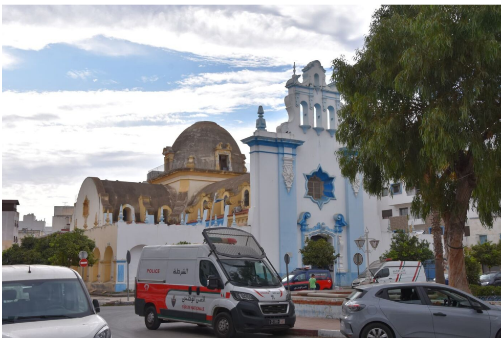
Fachada principal y cúpula del Centro Lerchundi
